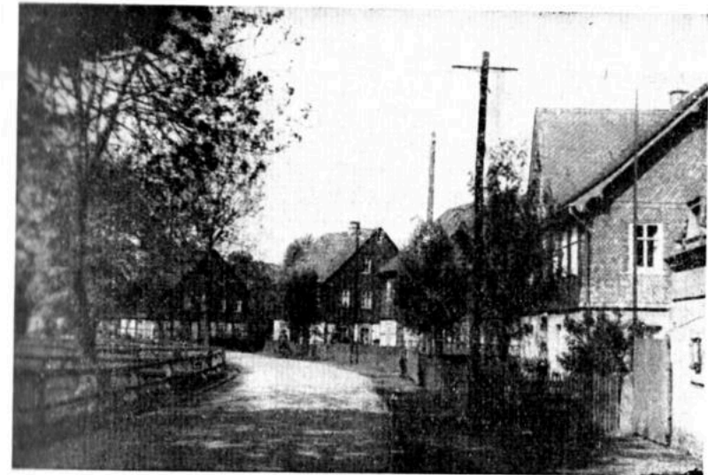
Schieferhäuser an der Dorfchemnitzer Straße
