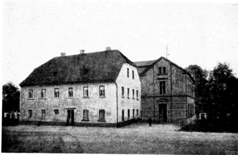
Die Kirchschule (1837 bis 1907) Haus Straße der Befreiung 105)
